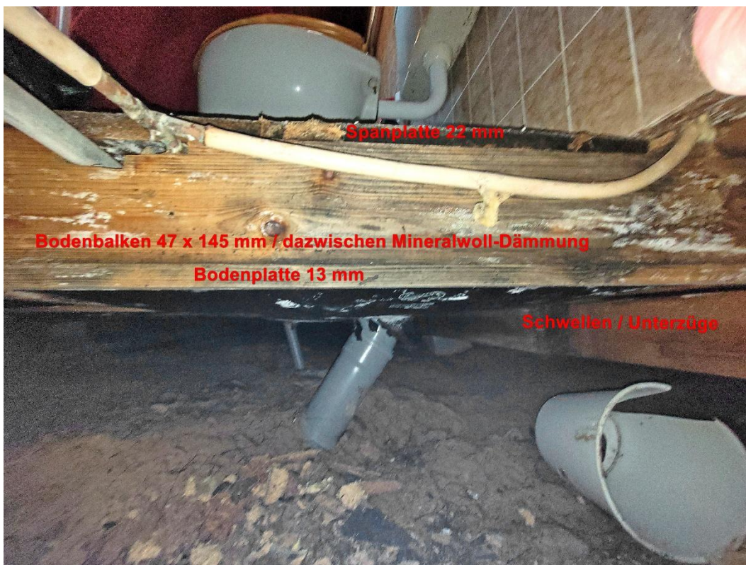
Bodenaufbau laut Statik / Baubeschreibung
