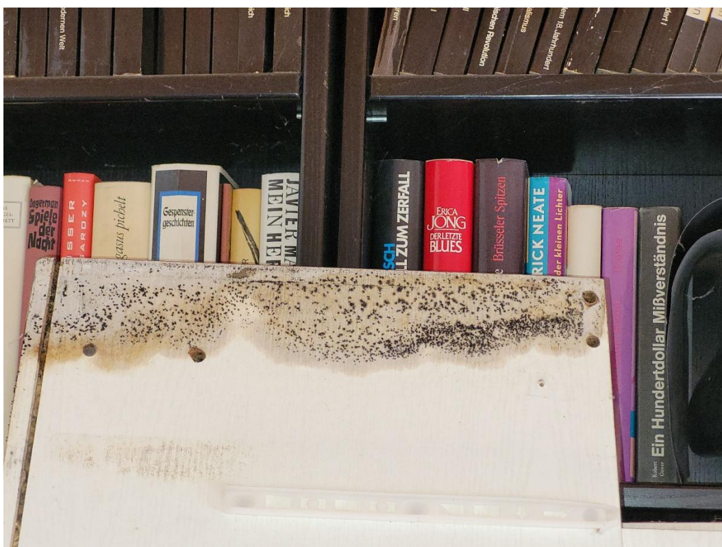
Kinderzimmer: beschädigte Schrankwand aus dem Schlafzimmer
