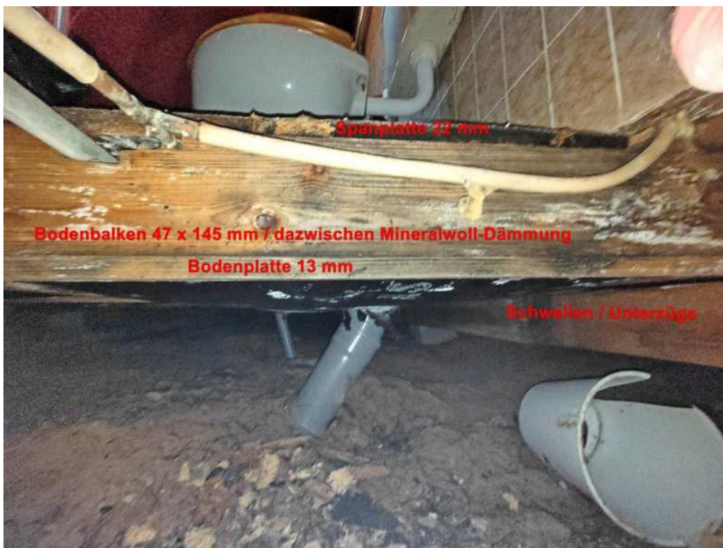
Bodenaufbau laut Statik / Baubeschreibung
