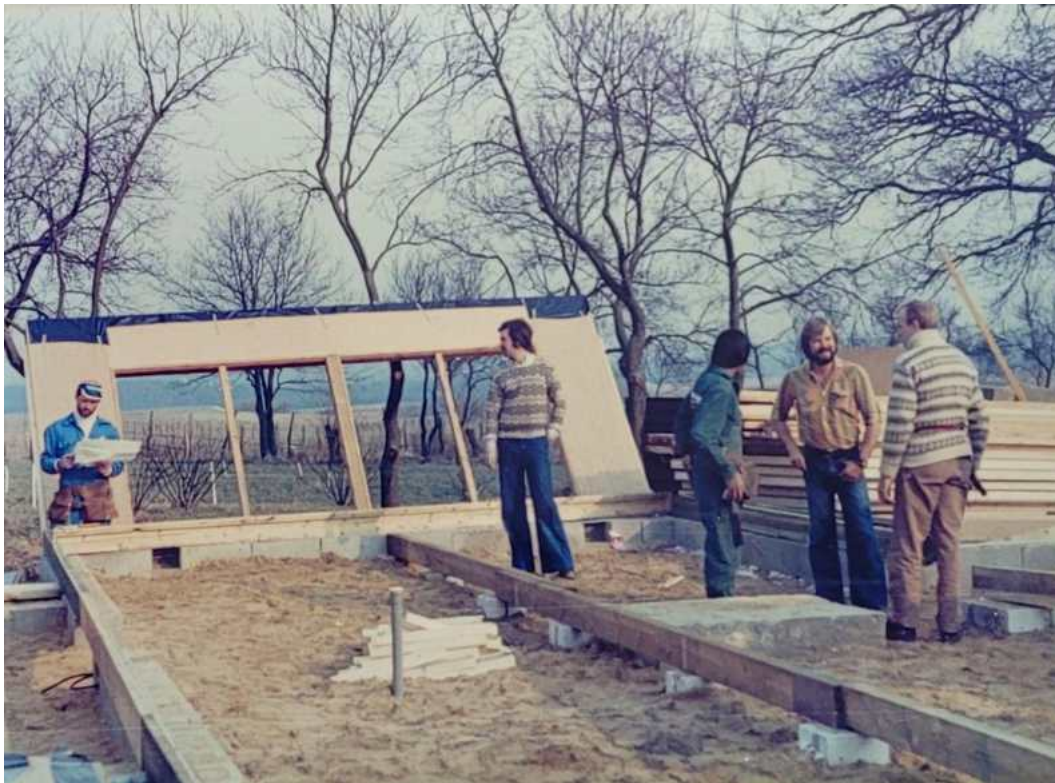
Bodenaufbau: Ringfundament mit unterster Schwelle (Foto aus der Bauphase)
