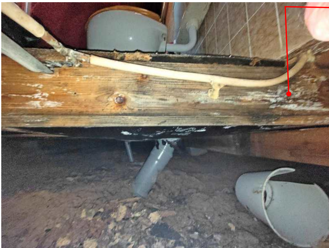
Holzschäden: (Holzschwamm?)
