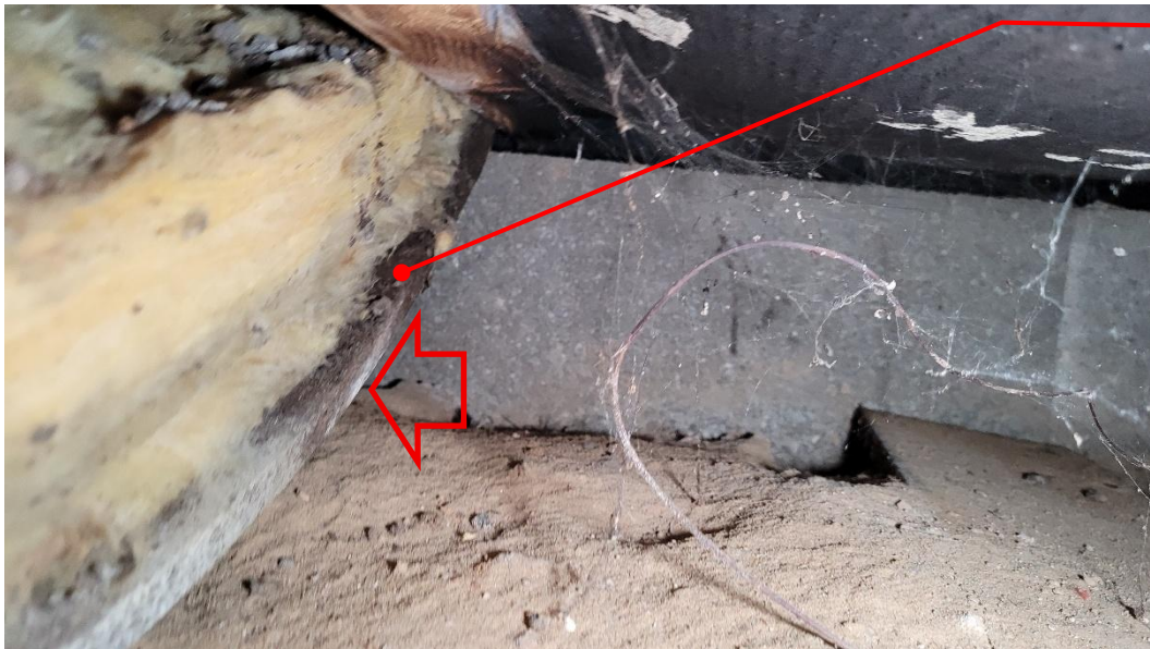
Schlafzimmer aufgelöste / aufgewölbte Bodenplatte
