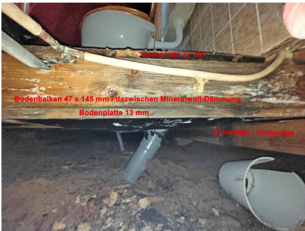
Bodenaufbau laut Statik / Baubeschreibung
