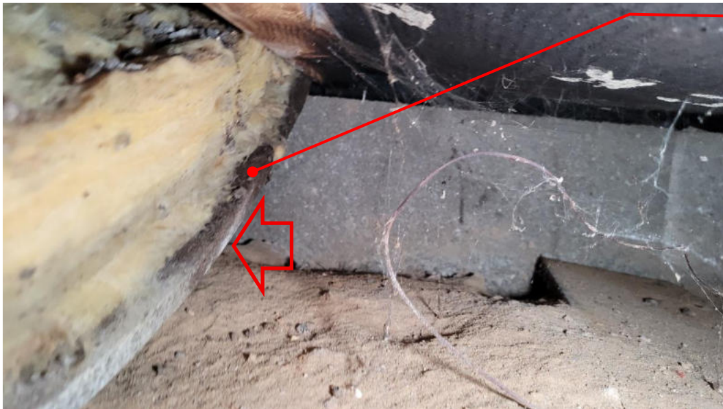
Schlafzimmer aufgelöste / aufgewölbte Bodenplatte
