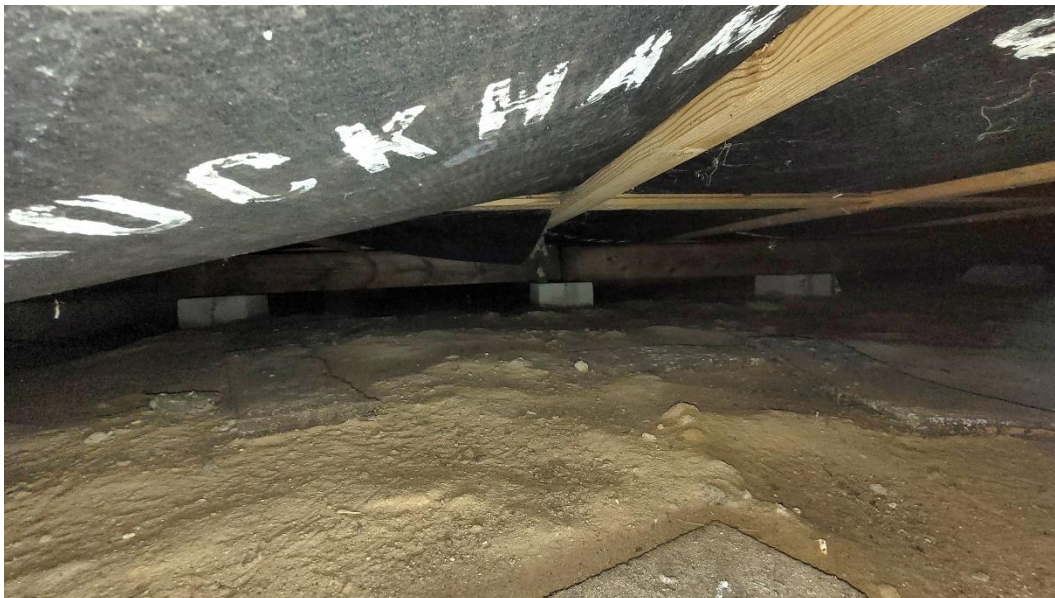
Geöffnete Schadensstellen: herabhängende Bodenplatten unter Küche / Wohnzimmer
