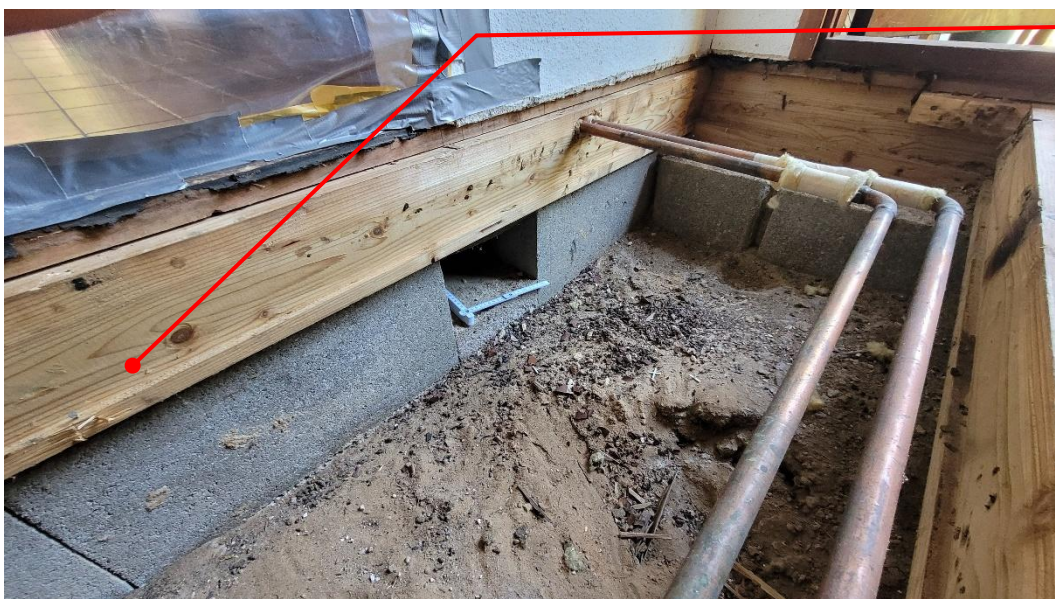
Geöffnete Schadensstellen: herabhängende Bodenplatten unter Küche / Wohnzimmer
