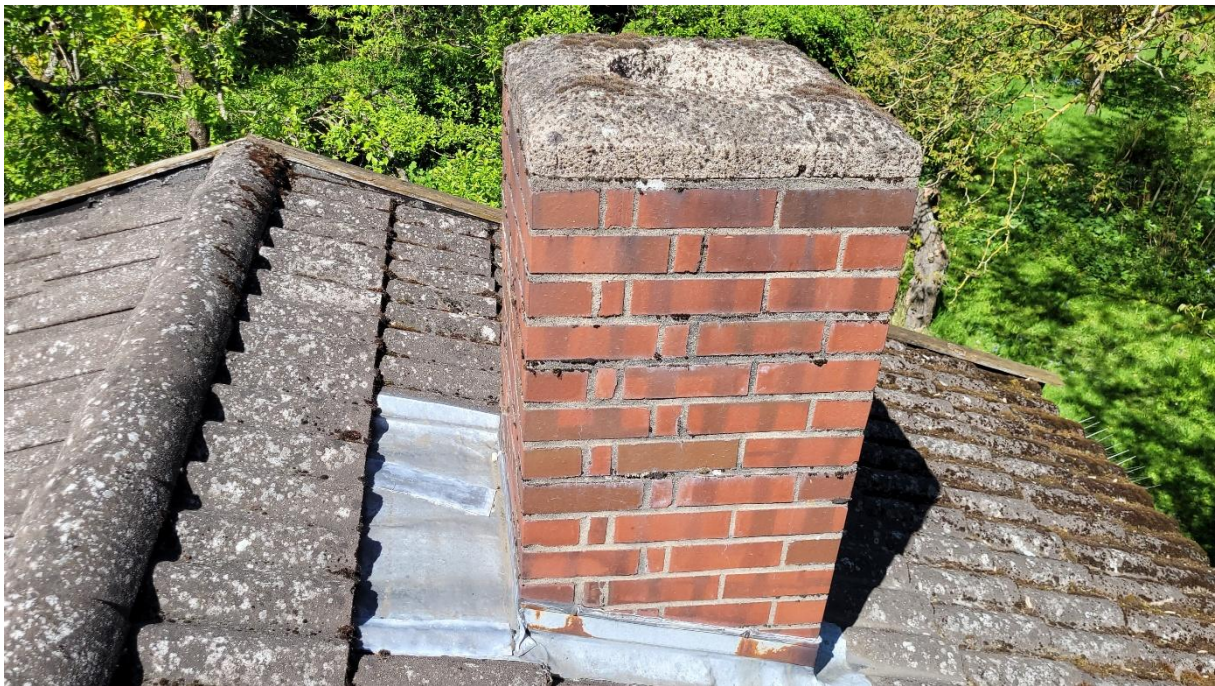
Dach über dem Heizungsraum: Dach, Schornstein
