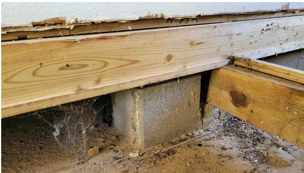
Durchlässe / Öffnungen in den Streifenfundamenten
