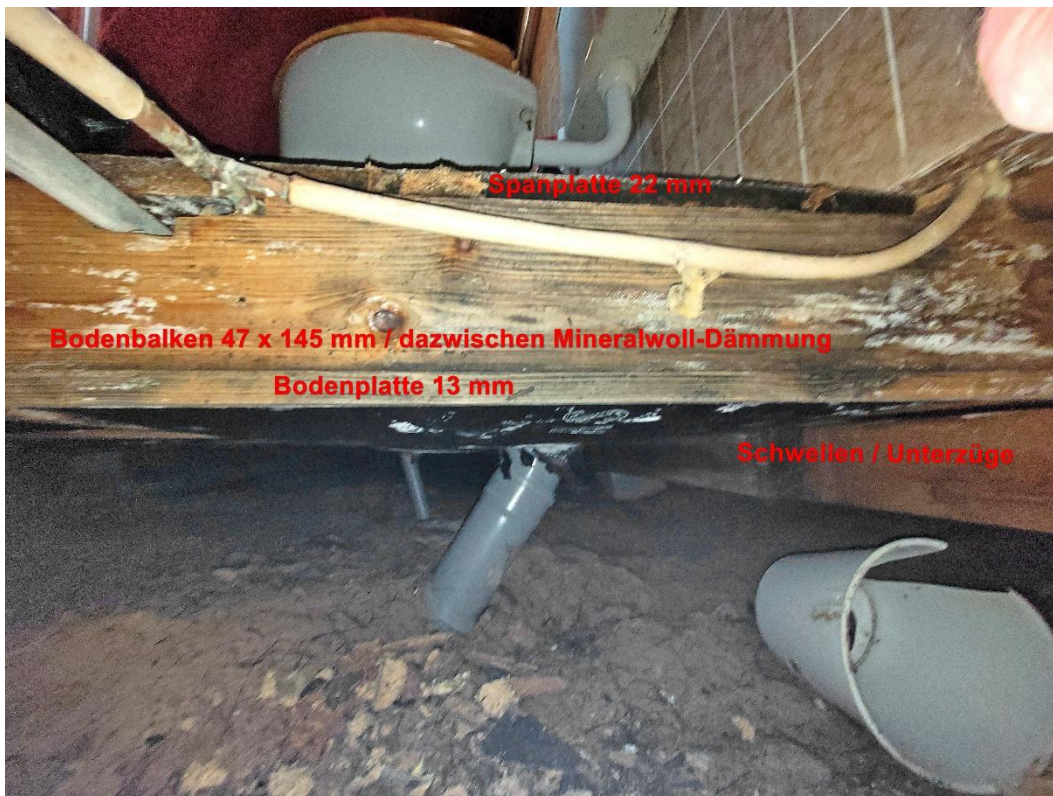
Bodenaufbau laut Statik / Baubeschreibung
