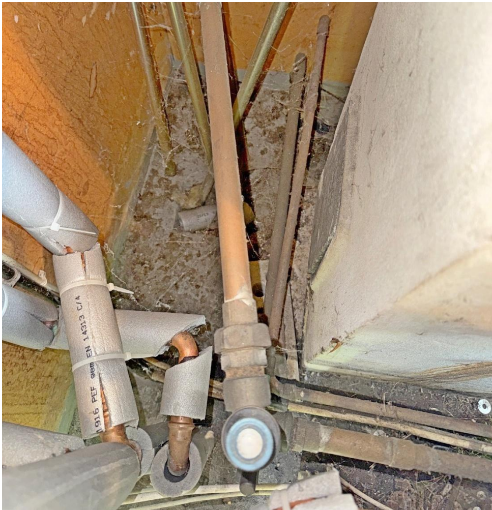
Heizungsraum: Fuß des Schornsteins / links Wand zum Schlafzimmer
